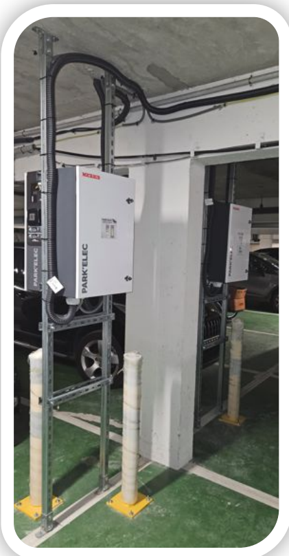
Armoire tout-en-un (ParkBox 7) fixée sur un support sol-plafond en l'absence de mur
