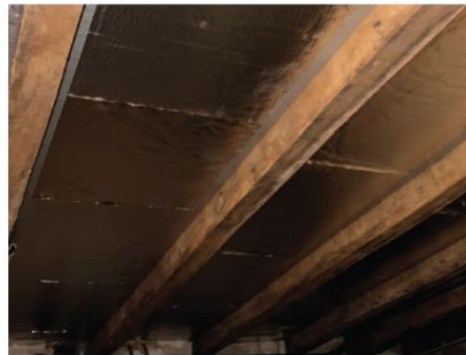
BAR-EN-103 : isolation d'un plancher
