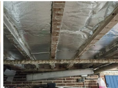
BAR-EN-103 : isolation d'un plancher
