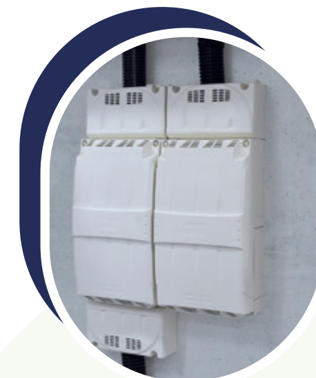
SPCM placés dans un parking comportant 2 travées
